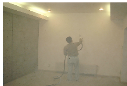
ガン吹きによる施工
