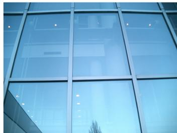
2003年8月竣工の北海道大学創成科学研究棟です。汚れ防止を目的に、真ん中のガラス面に施工しました。ガラス面は他の部分よりも5m奥に入っており、上部にゴンドラやクレーン設備が設置できないデザインのため、設計変更されるはずでした。しかし、エンゼルクリーンだけで美観を保持できるということで、清掃用設備なしで建設されました。
