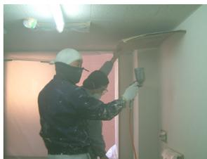
東京都荒川区の総合病院での施工例です。試験施工前に壁から大腸菌検出されました。天井と壁に施工して1週間経過後に、細菌は全く検出されませんでした。
